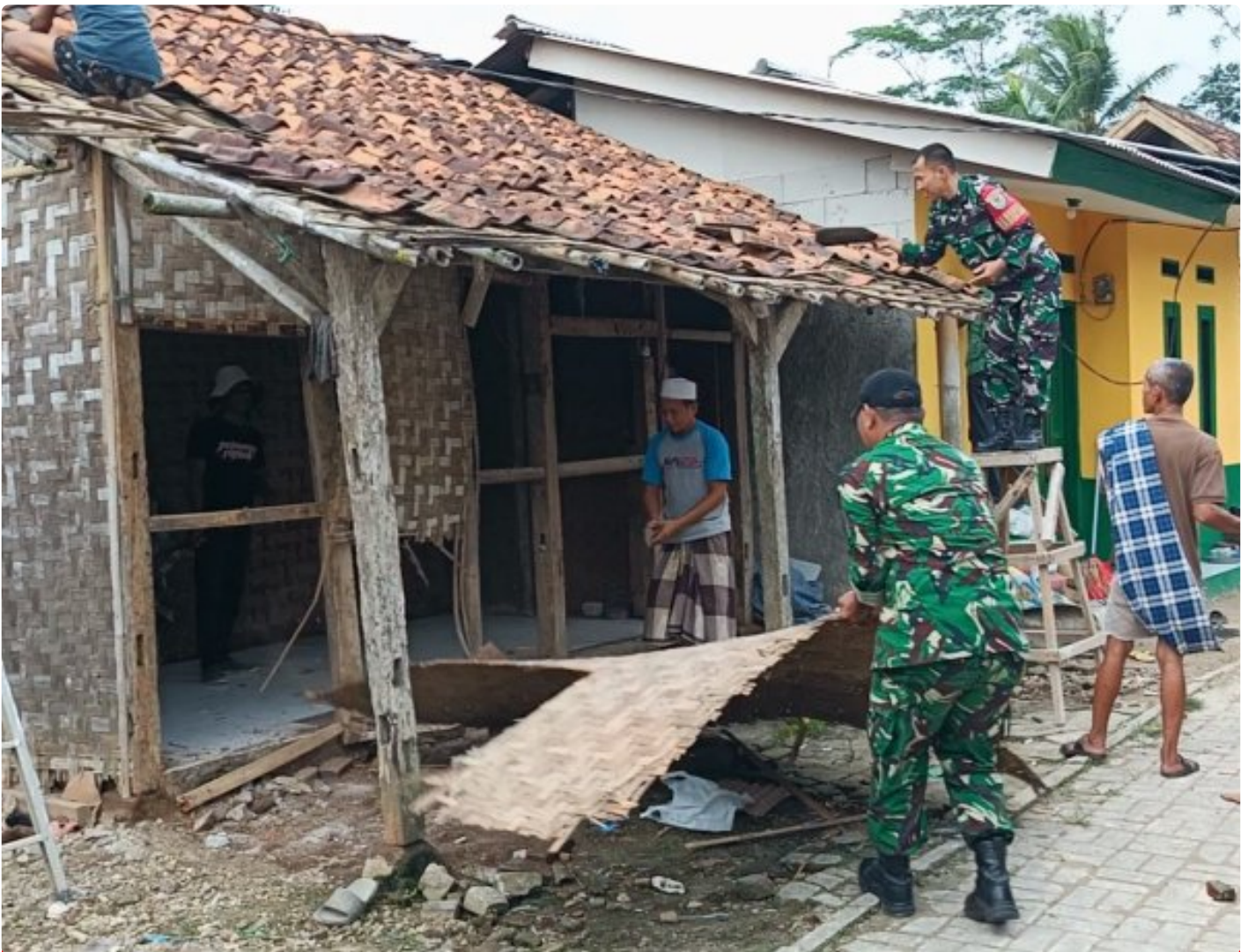
Pembongkaran Rumah Bapak Narmin
